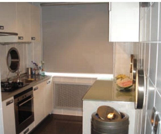
W kuchni na ścianach ułożono w poziomie matowe płytki oddzielone pionowymi błyszczącymi listwami. Na podłodze gres polerowany odbijający oświetlenie halogenowe wmontowane w napinany sufit
